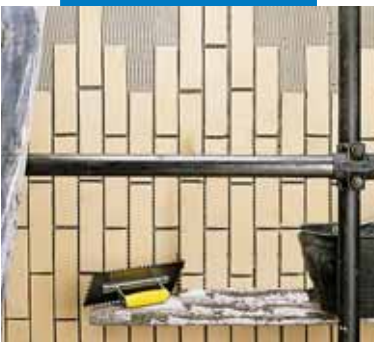
Posa a parete in esterno
